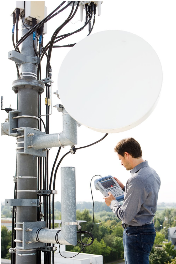
R&S® FSH를 사용한 기지국 설치 및 유지 관리
